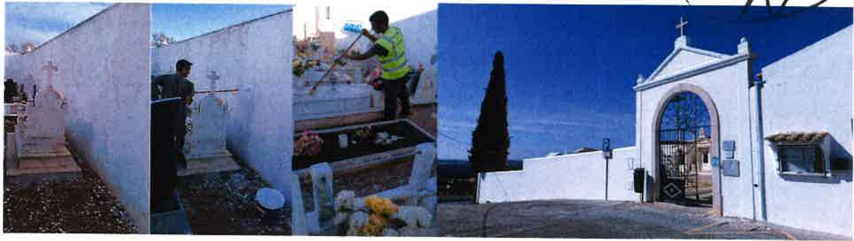
Imagem 5 – Serviços de reparação e manutenção do cemitério
