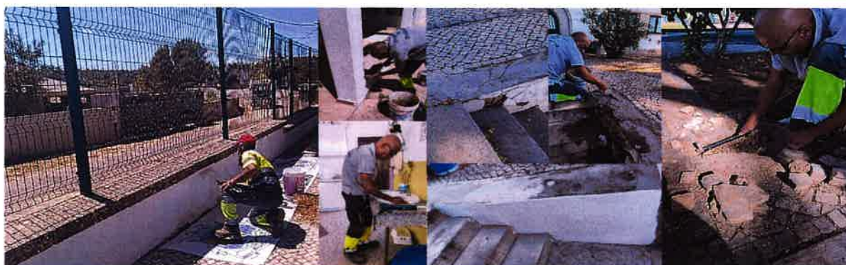
Imagem 14 - Reparações na Escola de Vale Silves
