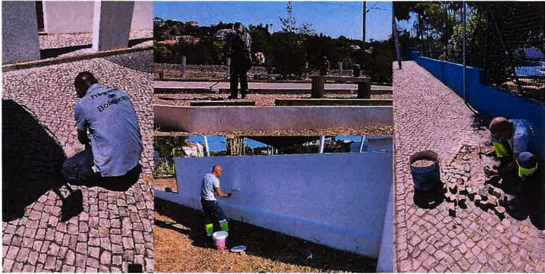
Imagem 4 - Reparação e Manutenção de Espaços públicos
