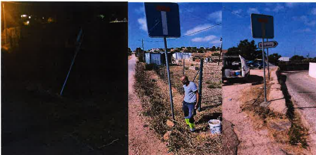
Imagem 2 – Reparação de Sinalização vertical danificada.
