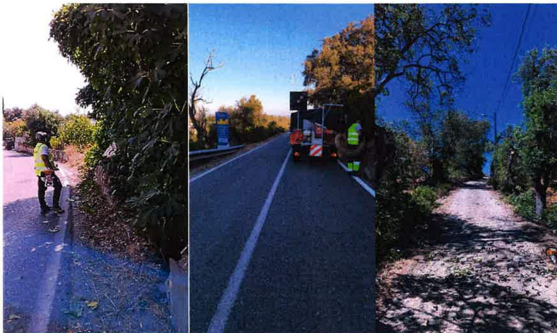
Imagem 10 - Limpeza de Bermas, Valetas e Caminhos
