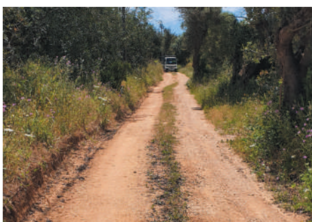
Beco da Cerca da Areia
