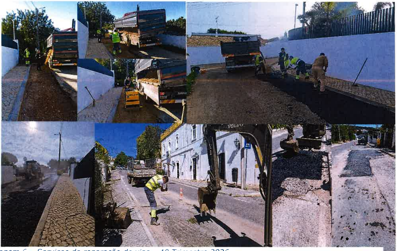
Imagem 6 – Serviços de reparação de vias – 1º Trimestre 2026
