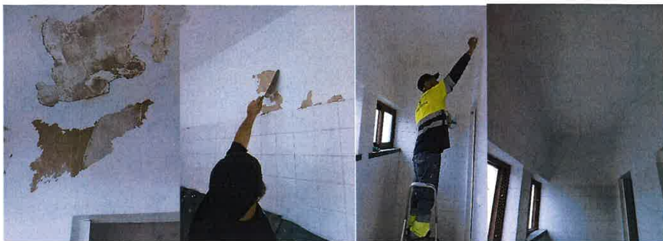
Imagem 11 – Reparações nas casas de banho públicas
