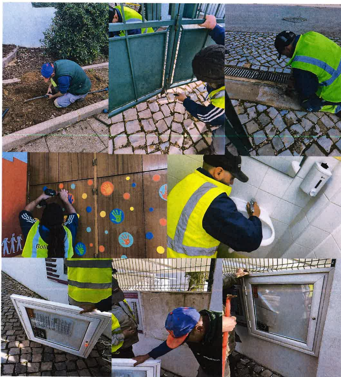
Imagem 12 – Intervenções na Escola das Benfarras
