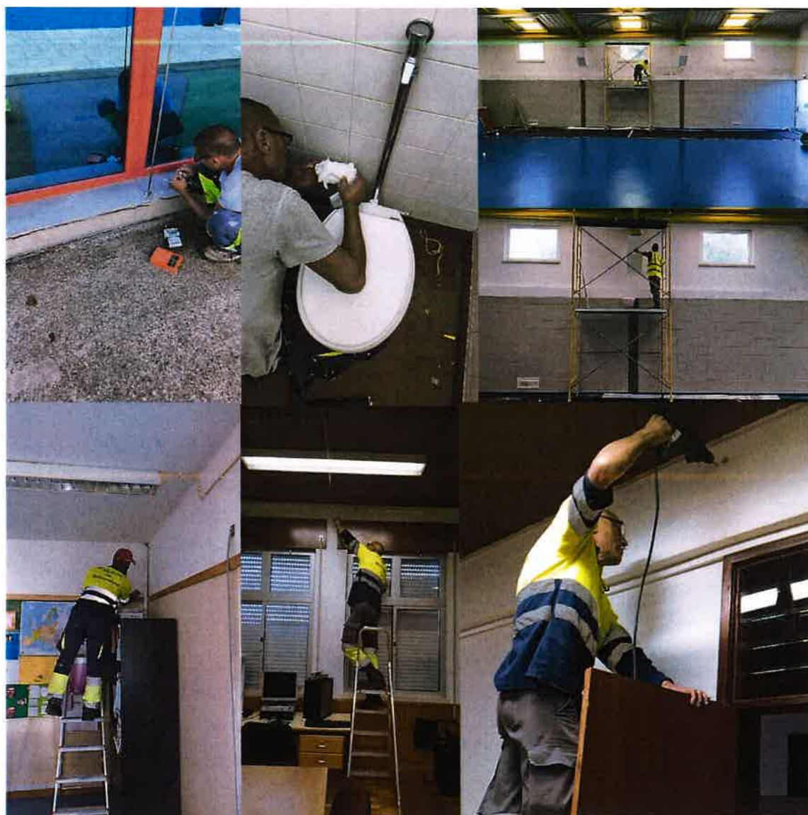
Imagem 13 – Intervenções na Escola Aníbal Cavaco Silva
