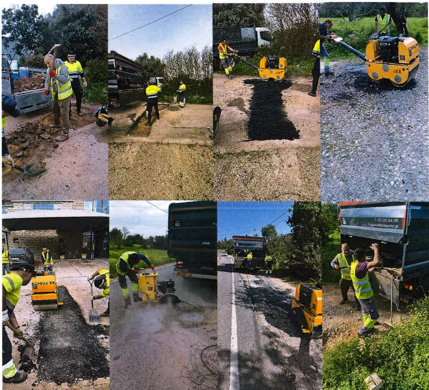
Imagem 7 – Serviços de reparação de vias – 1º Trimestre 2026
