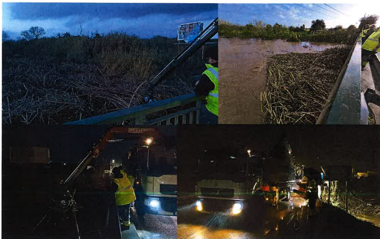
Imagem 9 – Intervenção na Ponte Barão
