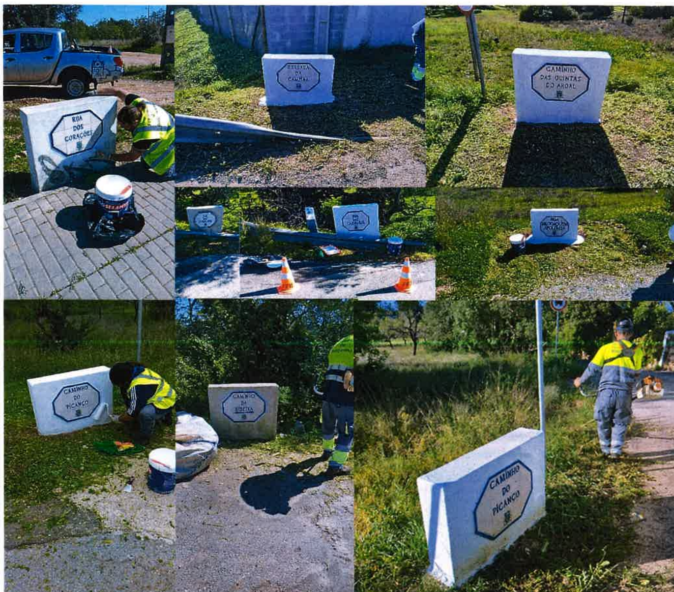
Imagem 3 – Reparação e Manutenção de Placas de Toponímia Existentes – 1º Trimestre de 2026
