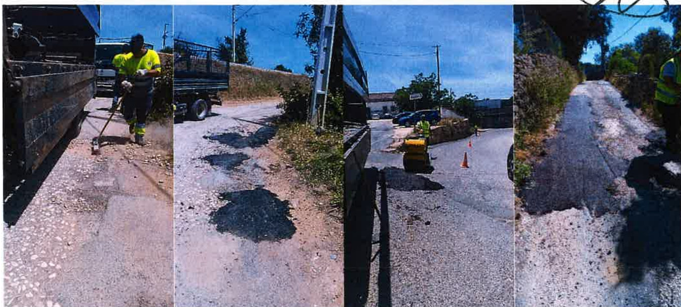
Imagem 3 – Serviços de reparação de vias – 2º Trimestre 2026
