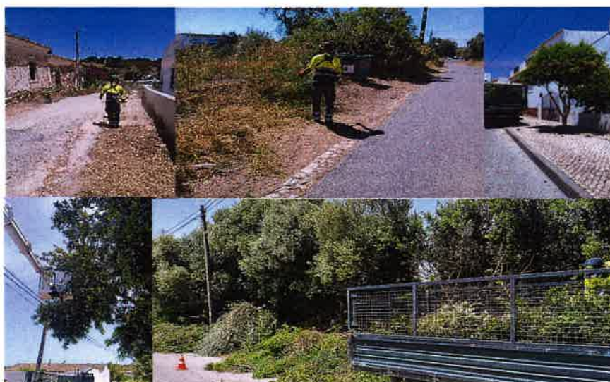
Imagem 4 – limpeza de bermas e cortes de árvores.
